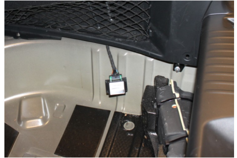
Rückbau der Seitenverkleidung
