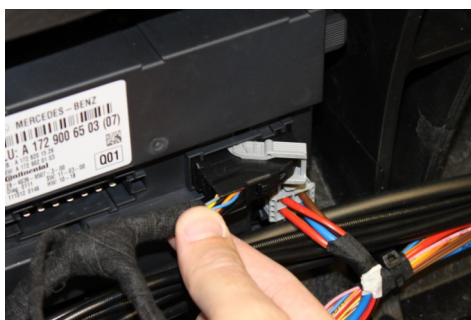
Modulkabelbaum in Steuergerät stecken
