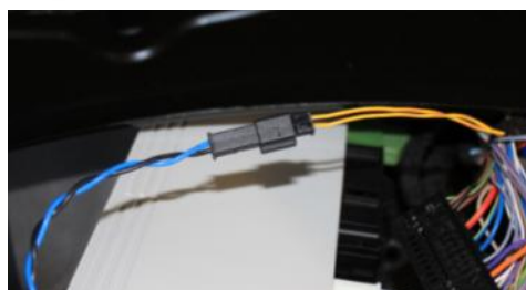
Einstecken der Kabel in das 2Polige Steckergehäuse und verbinden mit blau/schwarzem Kabelende
